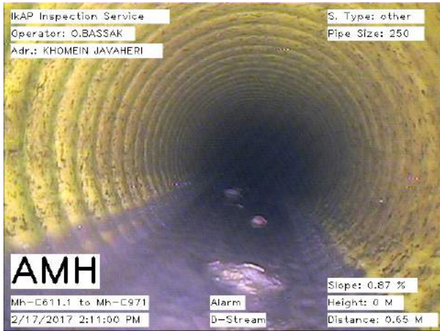
Photo : 0.jpg 0.65 m, Manhole # 1
