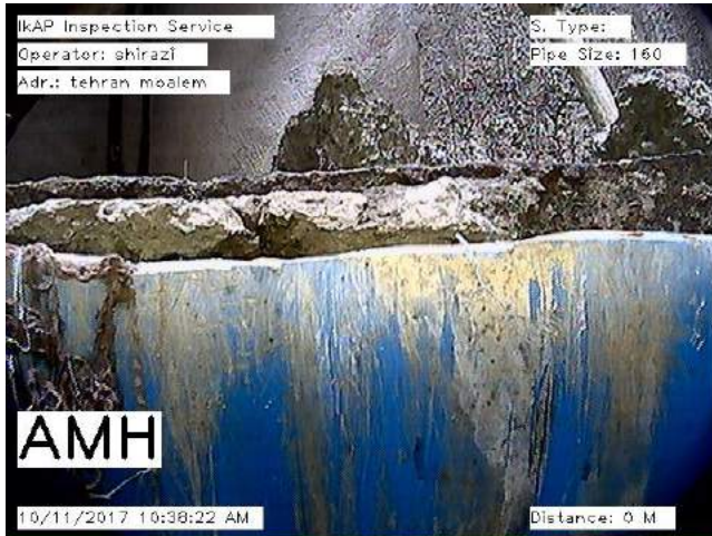
Photo : 0.jpg 0 m, Manhole # 1
